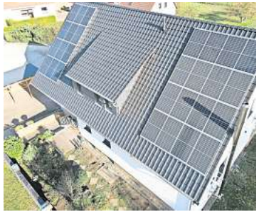
Energetische Sanierung: In Wirmingen hat ein Eigentümer sein Haus nicht nur gedämmt, sondern auch eine Photovoltaikanlage auf Dach setzen lassen. FOTO: PRIVAT
